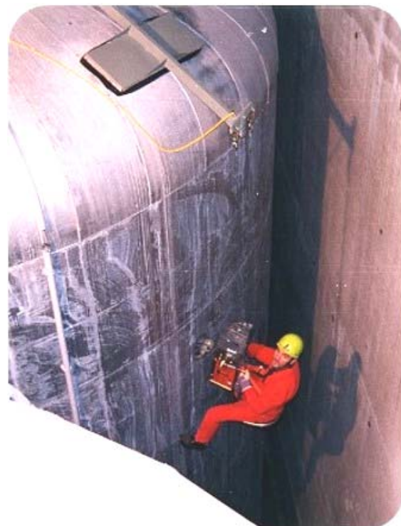
Arbeiten an einem Behälter
